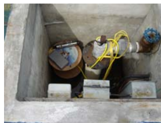
Foto N° 6. Vista de la instalación de la sonda WATER LEVEL LOGGER en el pozo, para la prueba de bombeo de 72 horas.
