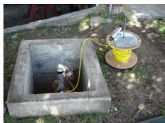
Foto N° 3. Sonda instalada y midiendo los descensos de nivel en el pozo.
