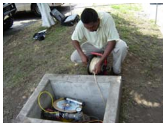
Foto N° 1. Pozo N°3: medición del nivel estático e instalación de la sonda WATER LEVEL LOGGER para realizar la prueba de bombeo de 72 horas.
