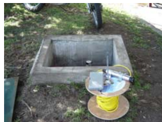
Foto N° 2. Vista de la caja protectora del pozo
