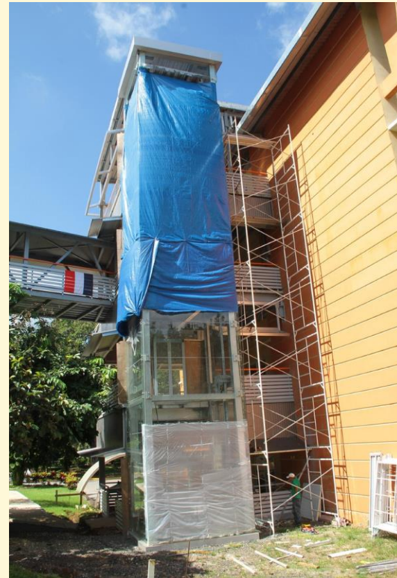
Ascensor Edif. 3 y Edif. 1
