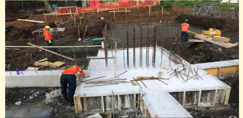
Construcción de Edificio de facilidades estudiantiles
