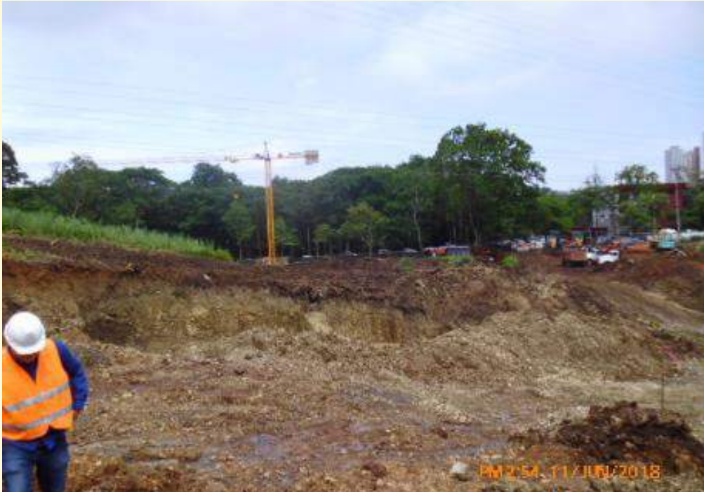
Construcción de Edificio de facilidades estudiantiles
