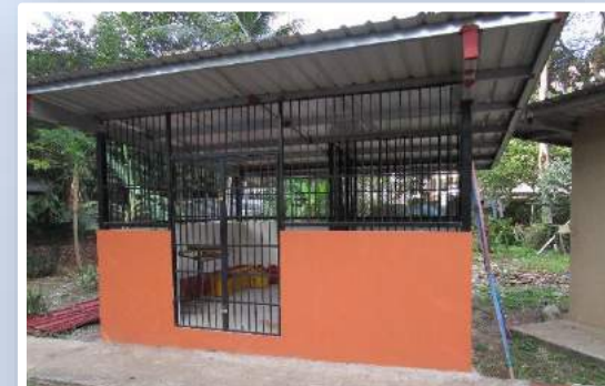
Depósito de Combustible
