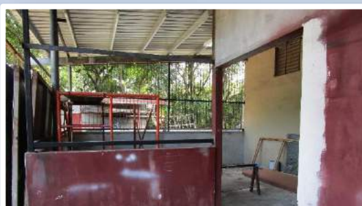
Área de trabajo de ebanestería / electricidad
