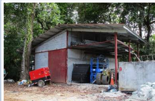
Depósito de Cemento
