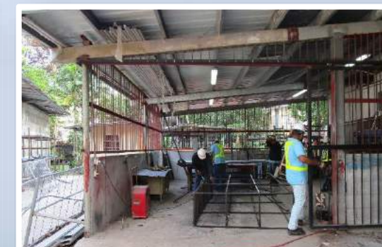
Área de trabajo de soldadura
