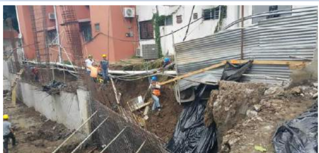
Muro Derrumbado en las oficinas administrativas (Orillac)
