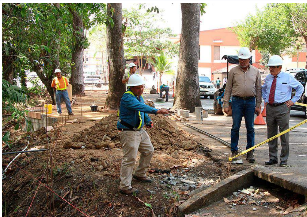
Ampliación de estacionamientos, Edificio Administrativo
