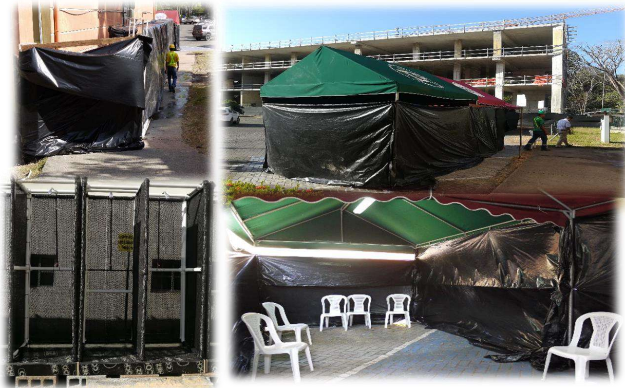
Instalación de duchas y vestidores para los participantes de la JMJ alojados en la UTP
