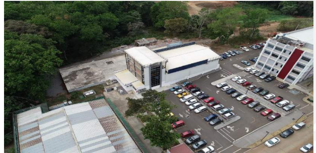
Edificio para el Laboratorio de Estructura
