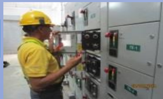
Mantenimiento e Instalación de Señalización a los Paneles eléctricos
