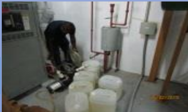
Suministro de Químico a las tuberías de agua fría
