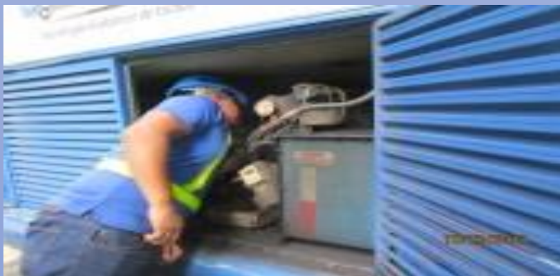
Reparación del Aire Acondicionado del Bus para Capacitación
