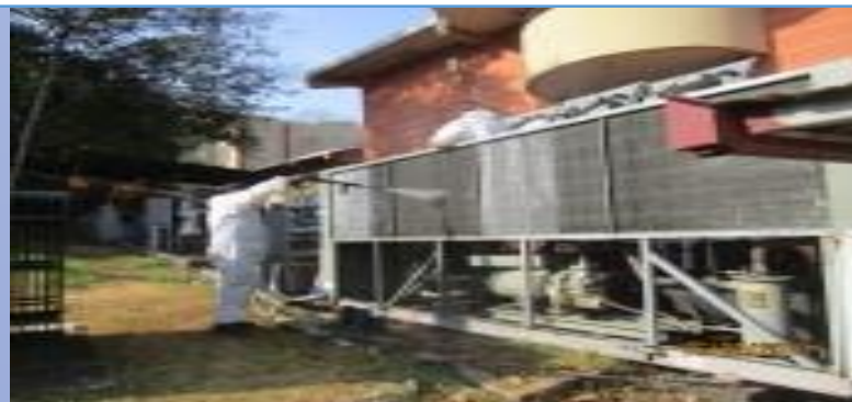
Limpieza de los Chiller en los diferentes Edificios de la UTP
