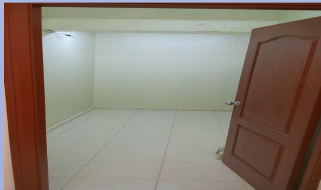
Instalación de Piso en Planta Baja del Edificio VIPE
