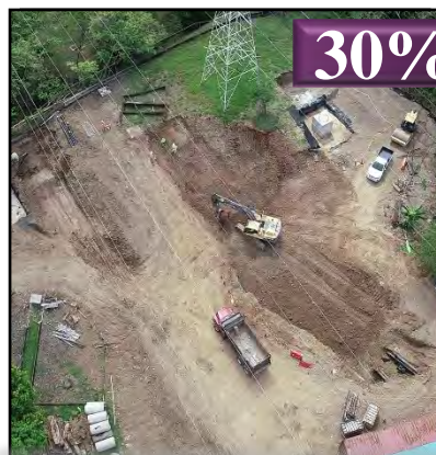
Soterramiento de 2.2 km de líneas de transmisión
