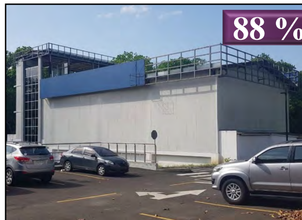
Laboratorio de Estructura
