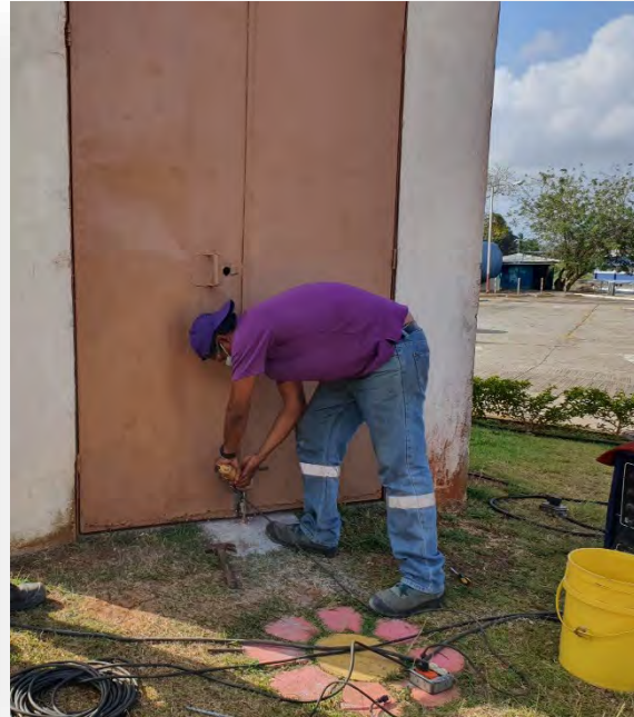
Rehabilitación del Tanque de Agua Potable en C. R. de Panamá Oeste
