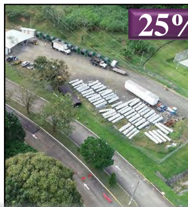
Soterramiento de 2.2 km de líneas de transmisión
