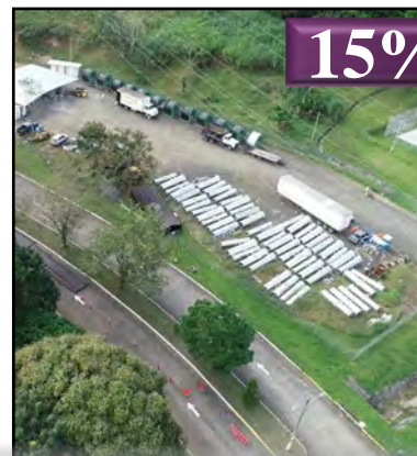
Soterramiento de 2.2 km de líneas de transmisión
