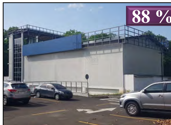
Laboratorio de Estructura
