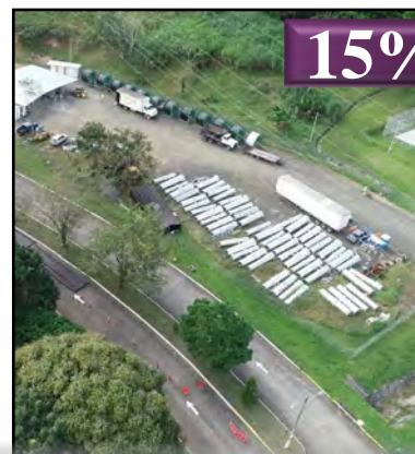
Soterramiento de 2.2 km de líneas de transmisión
