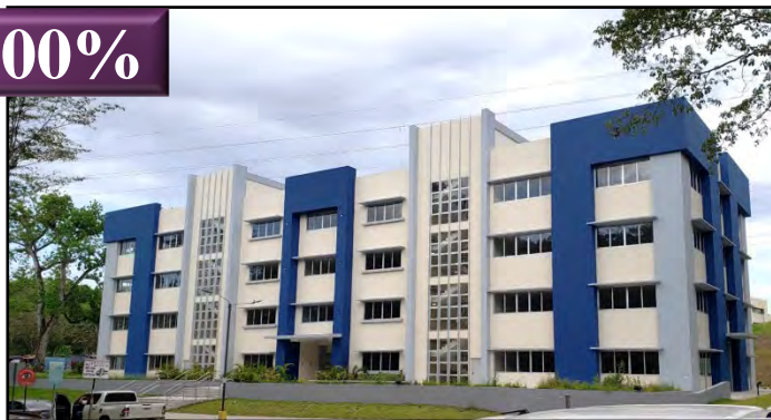
Edificio de Aulas
