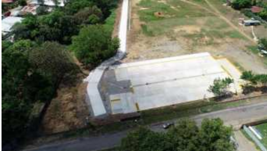
Construcción de Estacionamiento y Acera hacia la Cancha de Baloncesto, Centro Regional de Chiriquí.
