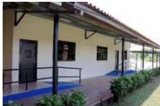
Construcción de la Sala de Conferencias del Centro Regional de Veraguas.
