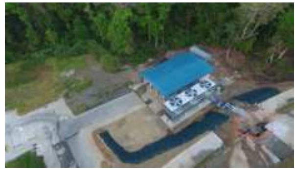
Casa de Máquinas.
