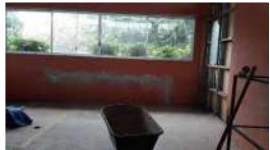
Construcción del Laboratorio de Fabricación Digital Fab Lab, Centro Regional de Chiriquí.
