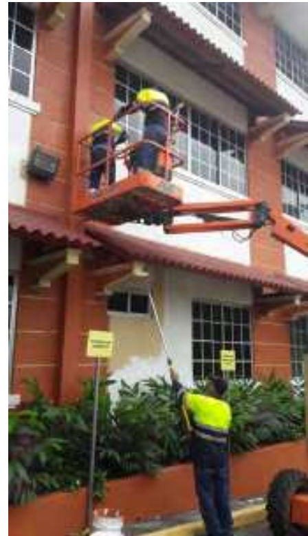
Remozamiento del Edificio No. 1.
