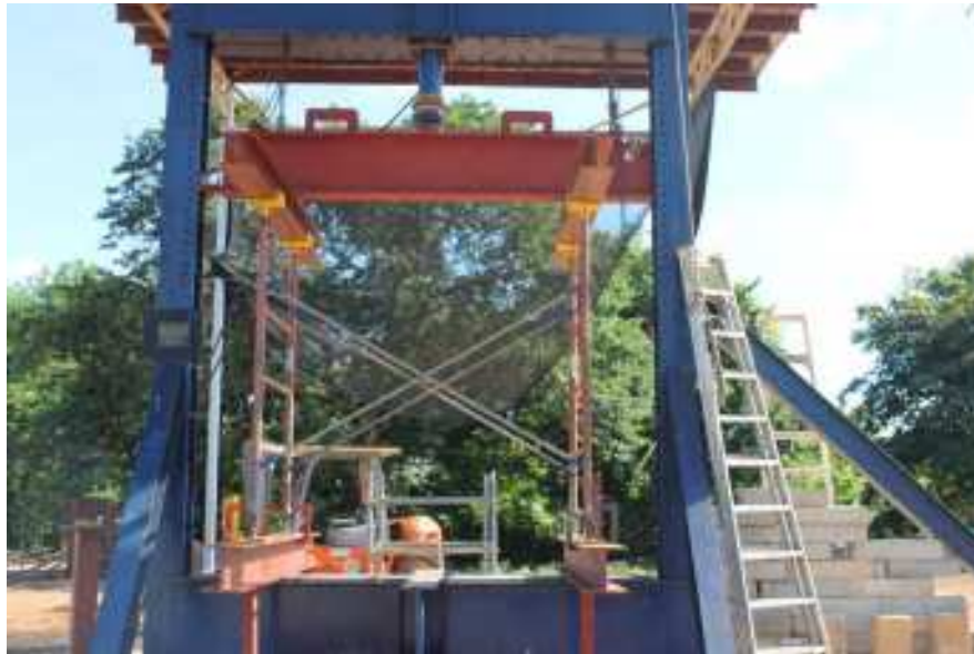
Ensayo a andamio de carga para la verificación de factores de seguridad y capacidad de carga.
