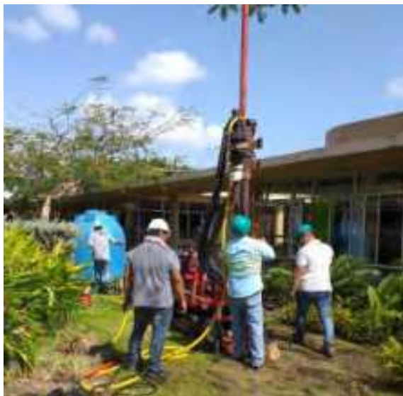
Perforación de suelo en la parte central de La Plaza Ciudad del Saber.
