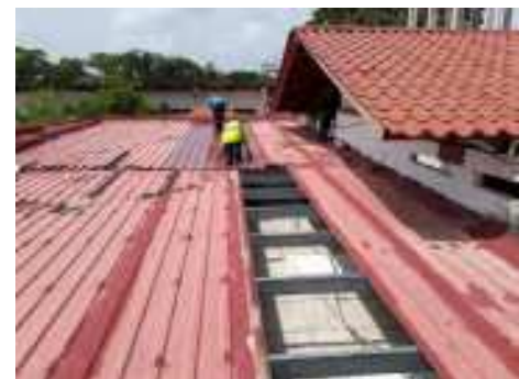
Reparación del techo del Edificio Administrativo, Centro Regional de Coclé.
