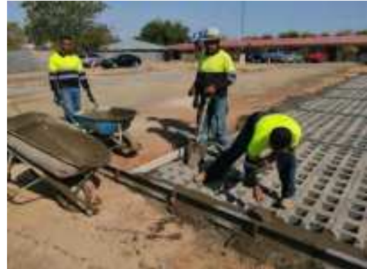
Trabajos de adecuación del estacionamiento del Centro Regional de Azuero.
