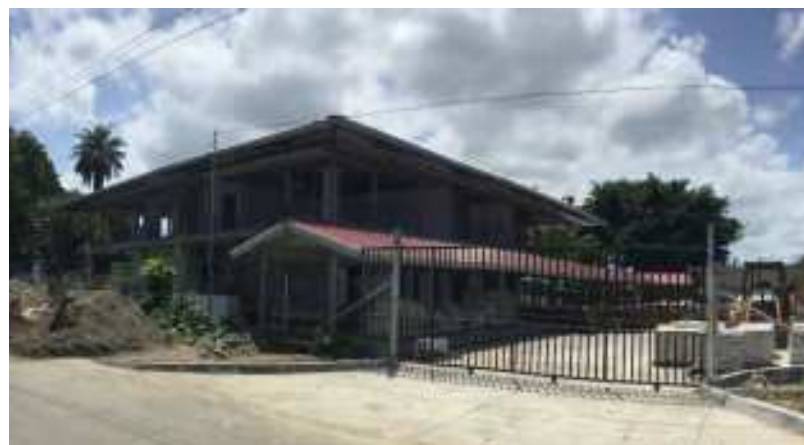
Construcción de Edificio en el Centro Regional de Bocas del Toro.
