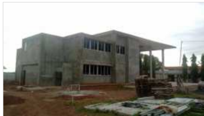
Edificio Núcleo de Servicios Especializados, Centro Regional de Veraguas.
