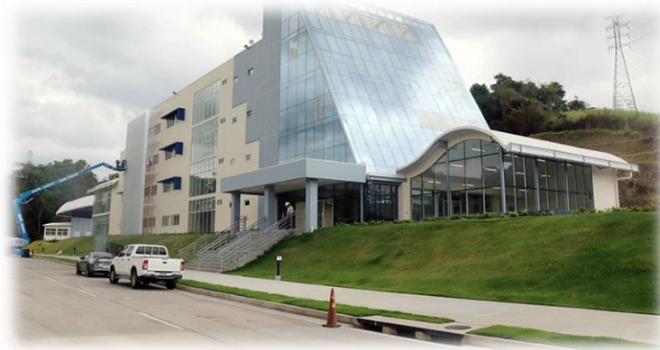
Edificio de laboratorios
