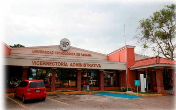
Edificio administrativo (Orillac)
