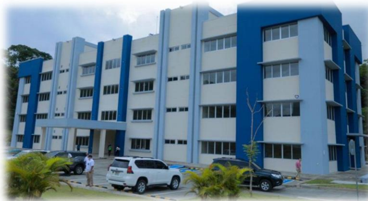
Edificio de aulas
