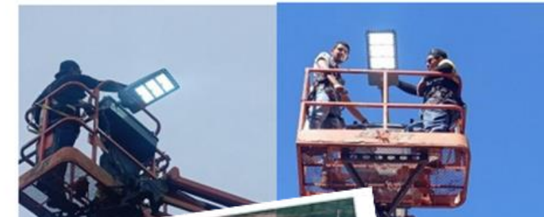
Imagen 9: Desinstalación de luminarias antiguas
