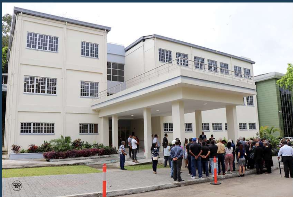
Edificio de Tecnología de la Información y Comunicaciones
